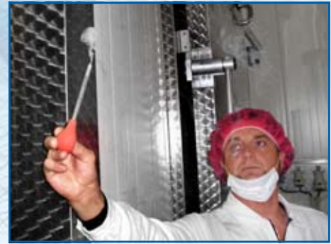
Überprüfung der Luftströmungsverhältnisse
