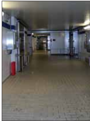
Dieser komplette Flurbereich wird von der entkeimten Luft durchströmt
