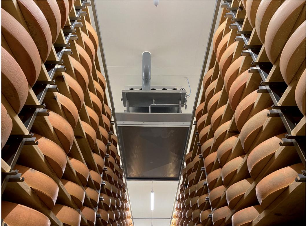
**Abb. 6** Ausbringung der nachhaltigen Hygienetechnologie über das *hygenic design* Umluftgerät ES-Jet während der Käsureifung (Quelle: Just in Air®)
