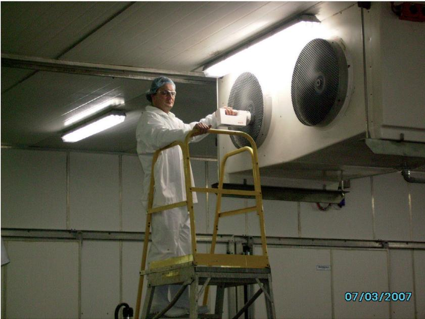
**Abb. 3 Erfassung der Luftkeimbelastung aus/in den Umluftreife-geräten** (Quelle: Just in Air®)
