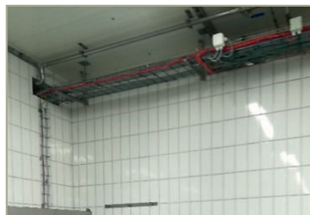
Abb. 12–14: Peripherie Einbauten mit starker organischer Belastung auf den Oberflächen.
