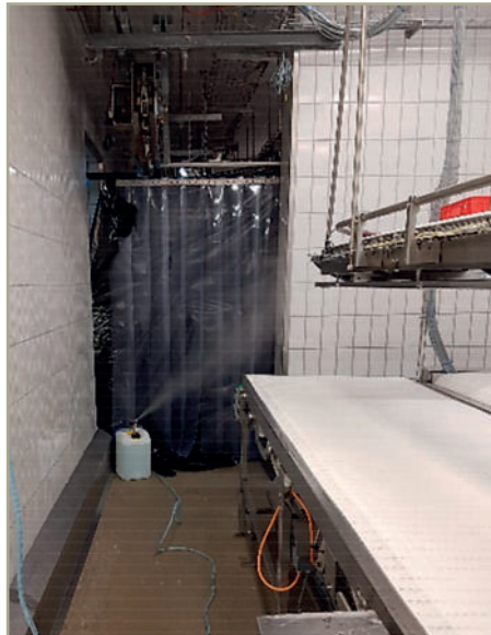
Abb. 3: Ausbringtechnik Deckeldüse Zerlegung Raum I.
