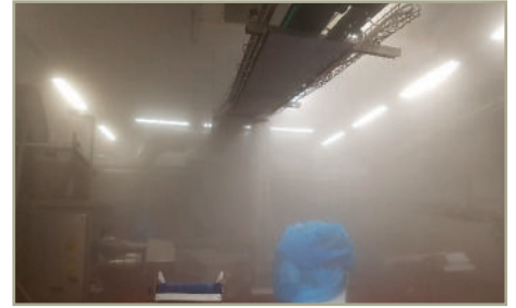
Abb. 11: Gleichmäßige Verteilung des Wirkstoffes in sämtlichen Bereichen des Raumes.
