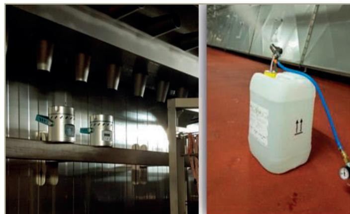
In allen Räumen wurden Oberflächenkeimmessungen in Form von Abklatschproben auf den produktberührenden Oberflächen und der Einbauten-Peripherie (Kabelkanal, Lampe, Rohrleitungen etc.) sowie Luftkeimmessungen vor und nach der Anwendung der alternativen Hygienetechnologie genommen.
