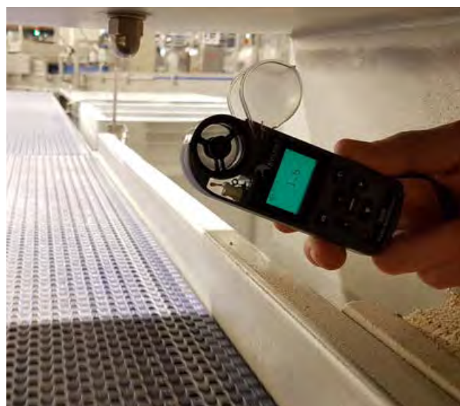
++ Luftströmungsvisualisierung zwischen Rein und Unrein
